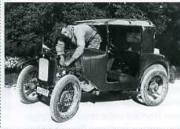
Der Besitzer ließ sich jedoch nicht entmutigen. Hier wird mit der Demontage aus dem Innenbereich heraus begonnen.
